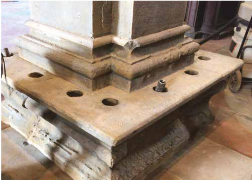
consistiti nello scavo per l'imposta di micropali in acciaio (Figg. 10, 11) a rinforzo delle fondazioni del pilastro imbibite d'acqua di falda, iniezioni di malte pronte consolidanti nelle murature, stuccatura e sigillatura delle lesioni esterne e rivestimento e ricostruzione delle parti mancanti con pietra nuova.
